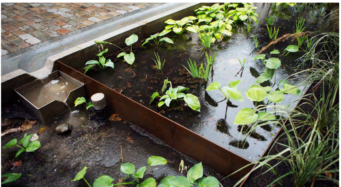
Regnbed i Deichmans gate med 25 cm nedsenk. Anlegget er dimensjonert for å håndtere totalt 60 m 3 vann, fordelt på 9 regnbed.
