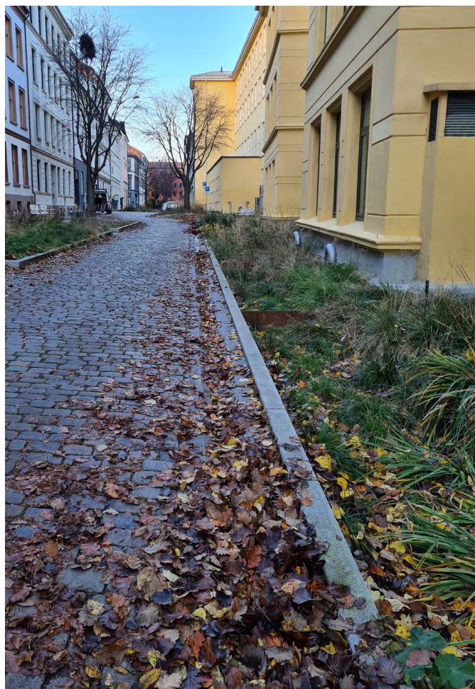
I Deichmans gate er det ikke plantet trær direkte i regnbedene, men det inngår flere store trær i anlegget. Løvet utgjør en ekstra driftsutfordring om høsten. Hvis det ikke fjernes fra renner og innløp, kan det blokkere vannets vei inn i regnbedene. Foto: Jan Inge Rygh
