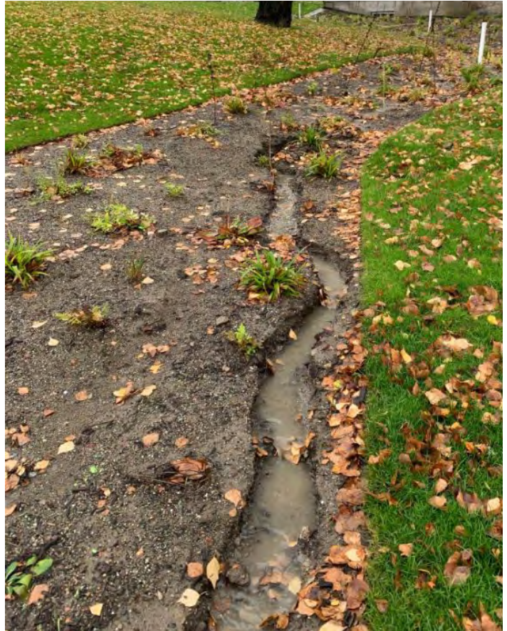
I dette anlegget håndteres overvannet i en kombinasjon av regnbed og vadi. Den skrå overflaten gjør tiltaket ekstra utsatt for erosjon. Problematikken forsterkes av at overvannet stammer fra taknedløp som gir vannet høy hastighet inn i vadien.
