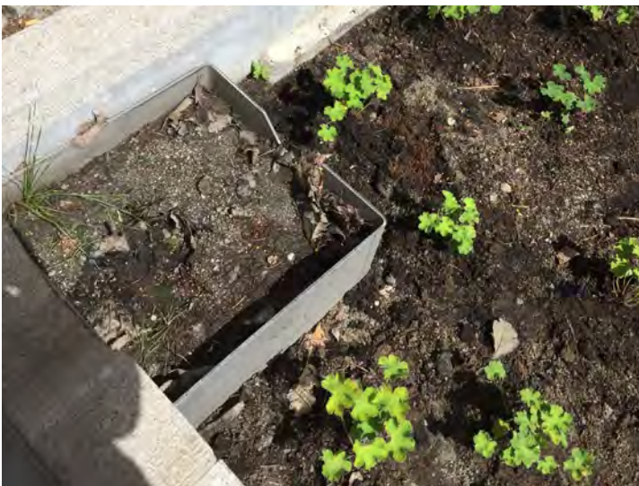
I Deichmans gate vedlikeholdes bed og regnbed av gartner, mens kommunens driftavdeling har ansvar for selve gata, renner og tømning av slamlommer. En helhetlig forvaltning av hele anlegget ville sannsynligvis vært både kostnadsbesparende og gitt et enda bedre helhetsinntrykk med hyppigere tilsyn av renner, innløp og slamlommer. Foto: Gerd Minde
