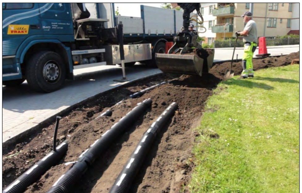
Savaq vanningsrør med jordveke som fører oppsamlet vann tilbake til jorda via kapillærkrefter. Bilder fra Savaqs brosjyre.
