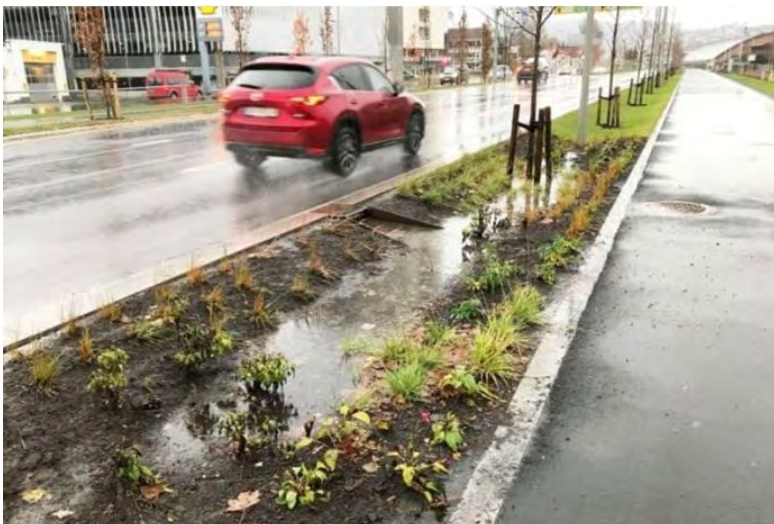
Det er stor forskjell på mengde og type belastninger regnbedplantene utsettes for i et veganlegg (over) sammenliknet med en park eller borettslag (til høyre). Plantevalget bør reflektere disse forskjellene slik at det velges mer robuste planter der det forventes mer ferdsel og trafikk. Foto over: Statens vegvesen.
