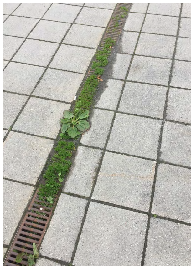
Bruk av Aco Drain i områder der avrenningen har med seg mye sedimenter øker faren for at renna går tett eller groir igjen.
