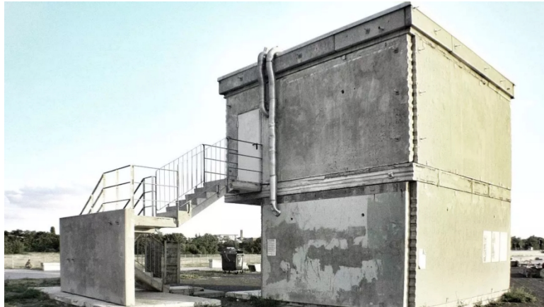
Figur 6: Paviljong av ombrukte betong dekker "Plattenvereinigung" i Berlin, (Küpfer et al., 2023; Tempelhofer feld, 2024).
