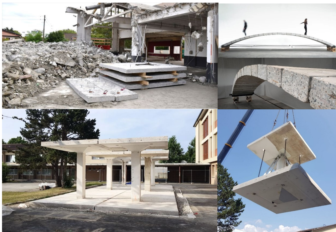
Figur 1: Bilder fra prosjekter i Sveits der ombruk av plasstøpt betong er prøvd ut, (Bilder fra presentasjon fra Structural Xploration Lab 2023-10-06).
