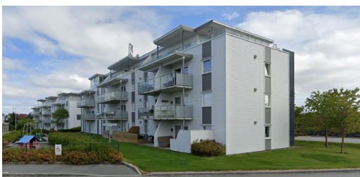
BEBYGGELSESTYPER D Lavblokker, del av Jåsund utbyggingen. Foto: Google maps.
