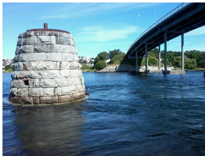
Rester av brulegemer fra gamle Hafrsfjordbrua. Foto: Rune Wersland.
